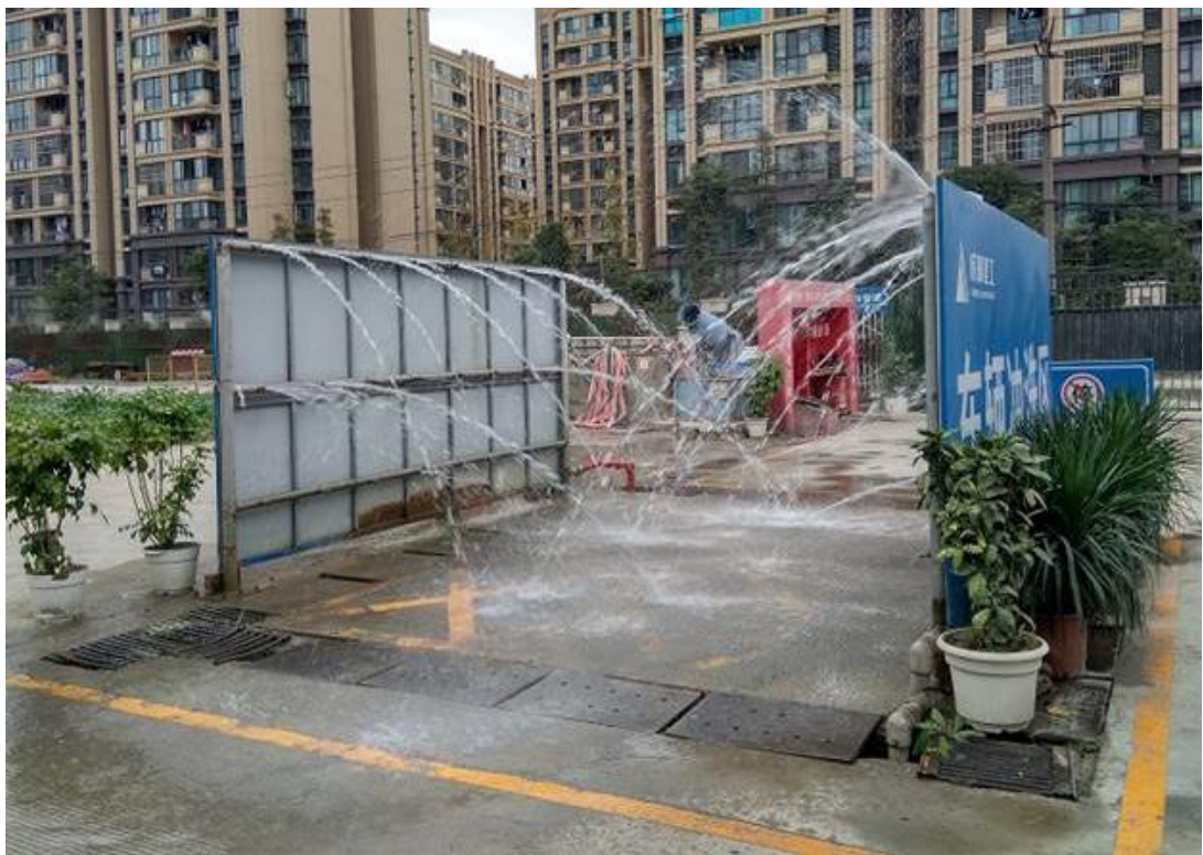
施工期场内洗车槽照片
