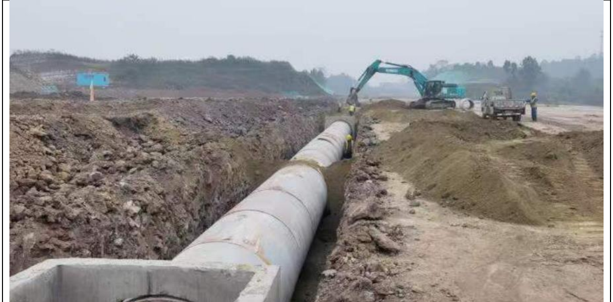
复兴路部分高挖高填区域和涵管施工区域现状
