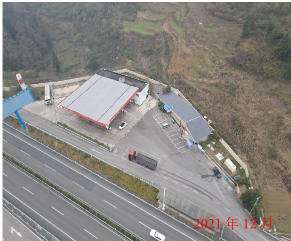
项目建设区东南侧
